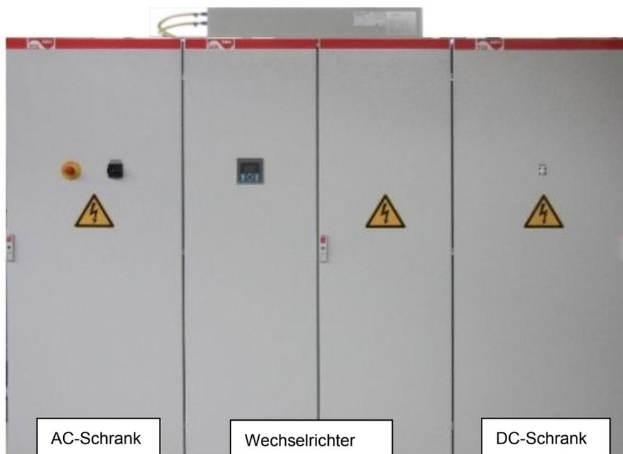
Bild Nr.9 Schrankansicht Solarwechselrichter 500 / 630K (Flüssigkeitskühlung - hermetisch geschlossen)
