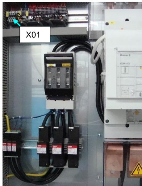
Bild Nr.22 AC-Anschluss Hilfsversorgung
