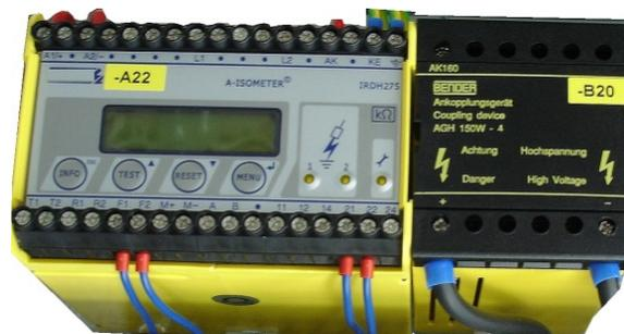
Bild Nr.24 Isolationsmessgerät
